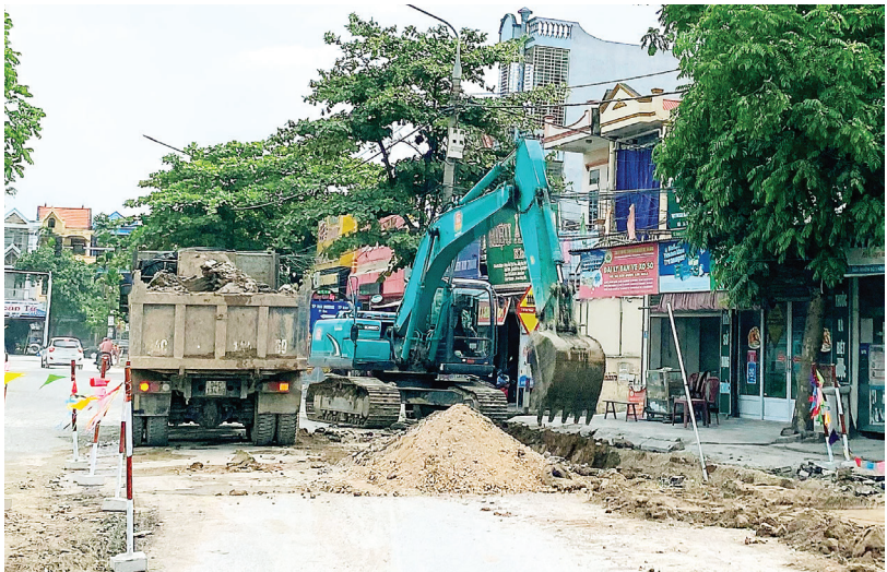
Công trình cải tạo, điều chỉnh tổ chức giao thông tại khu vực nút giao km15 + 835 quốc lộ 17B với đường 20.9 thị trấn Phú Thái đang được đẩy nhanh tiến độ thi công
